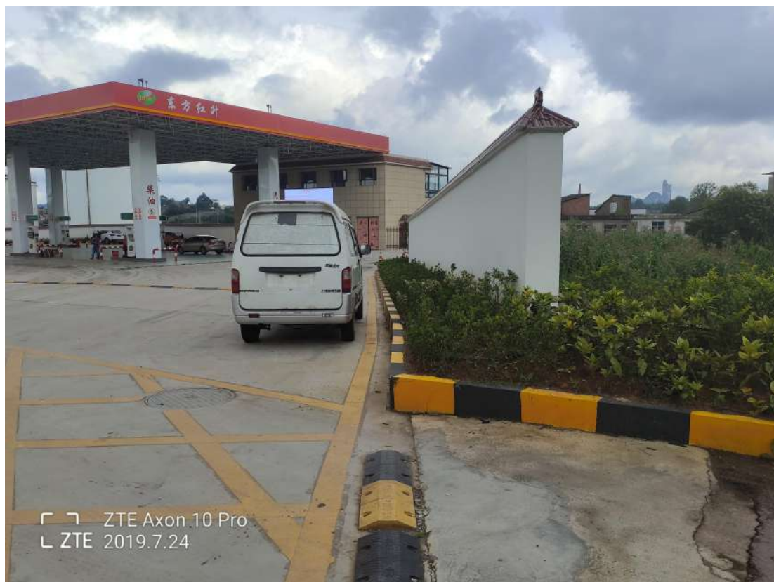
加油站进口现状
