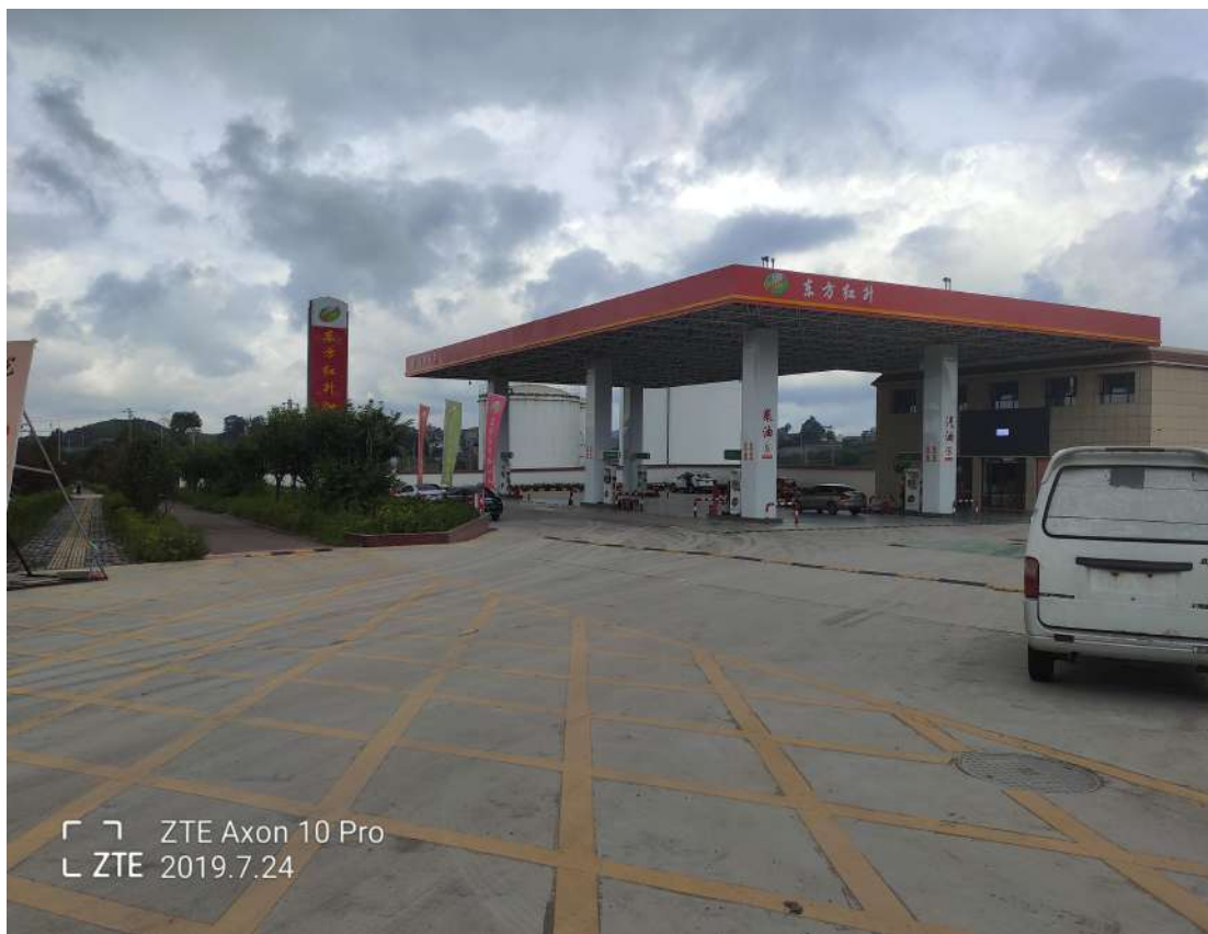
加油站进口现状
